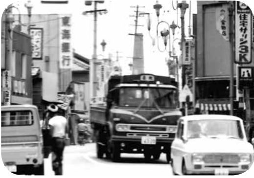
▲青木町の商店街。奥に瓦工場の煙突が。
