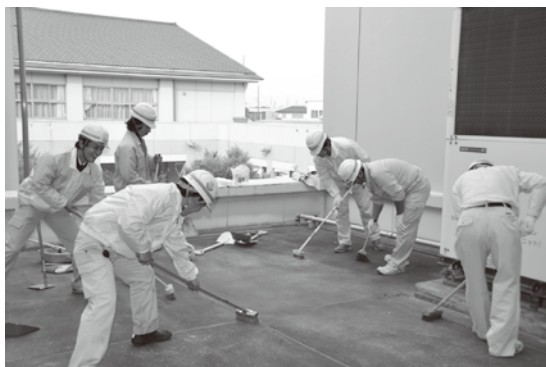
▲屋上をきれいにするぞー!
