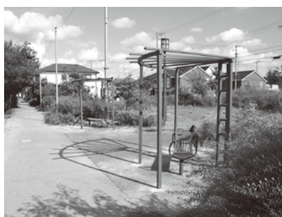
設置作業後の藤棚
