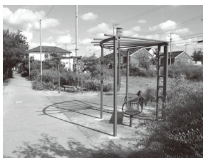
設置作業後の藤棚
