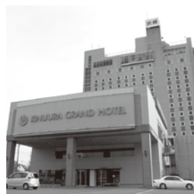
衣浦グランドホテル 大津波警報発令時、避難所として利用できます(標高5.3m)
