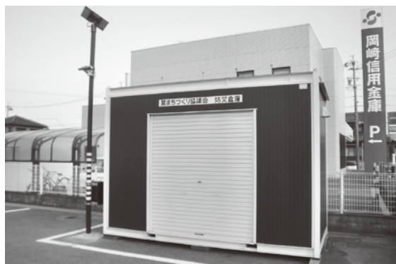
翼まちづくり協議会 防災倉庫と太陽光LED防犯灯の設置
