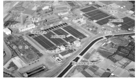
▲上野浄水場（東海市）
