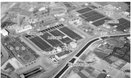
▲上野浄水場（東海市）
