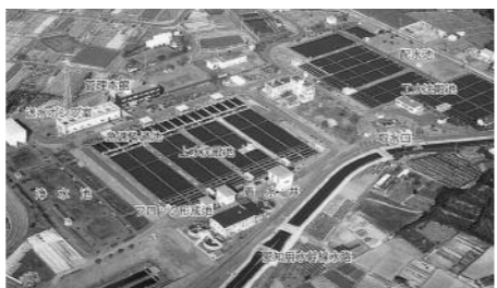
▲上野浄水場（東海市）
