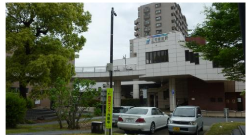
▲防犯カメラ設置 (三河高浜駅西口)
