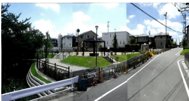
▲論地どんぐり公園 竣工直後の全景
