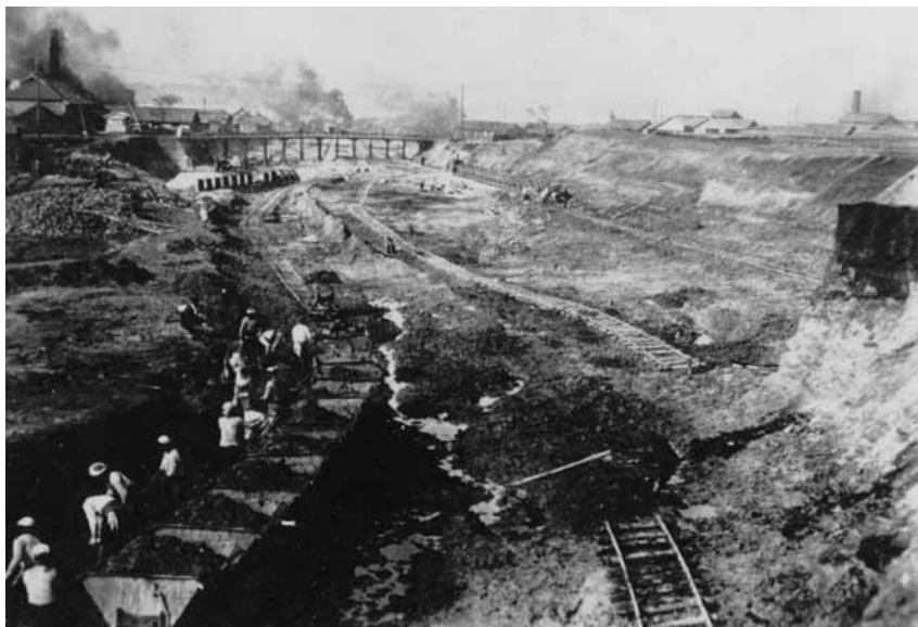
高浜川工事の写真。 背景に黒煙をあげる瓦 工場の煙突が見える。
