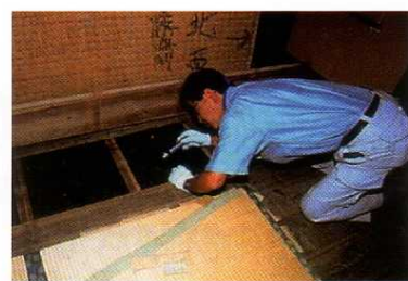
耐震診断員による床下点検
