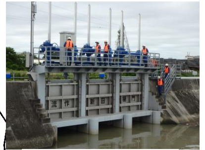
(流作新田樋門)
