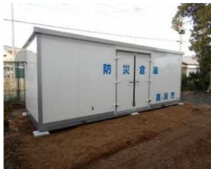
防災倉庫 (高浜中学校)
