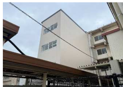
階段・EV棟
