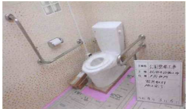
多目的トイレ手すり設置
