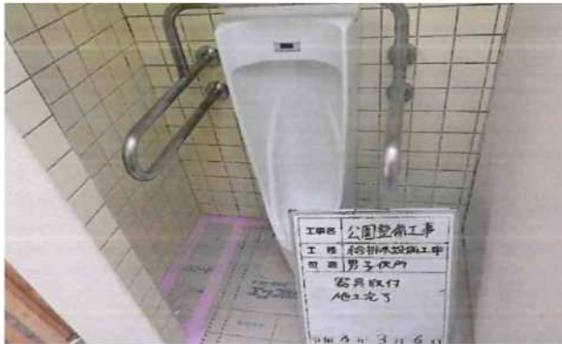
男子トイレ手すり設置
