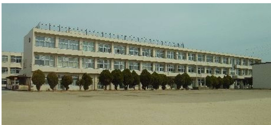
校舎外壁改修
