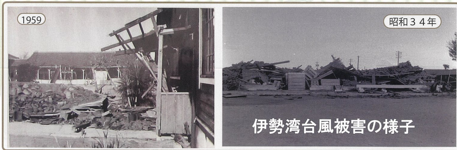
昭和34年9月26日午後9時～10時、「伊勢湾台風」台風15号が、名古屋の西を通過しました。進路の東側に入った愛知県西三河地域も凄まじい暴風に襲われ、沿岸部の碧南市や高浜市（当時は高浜町）では高潮が堤防を決壊させ大きな被害をもたらしました。吉浜小学校も瓦が落ちたり建物の損壊など大変な被害を受けました
