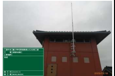
避雷針施工後
