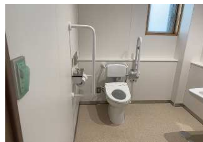
多目的トイレ
