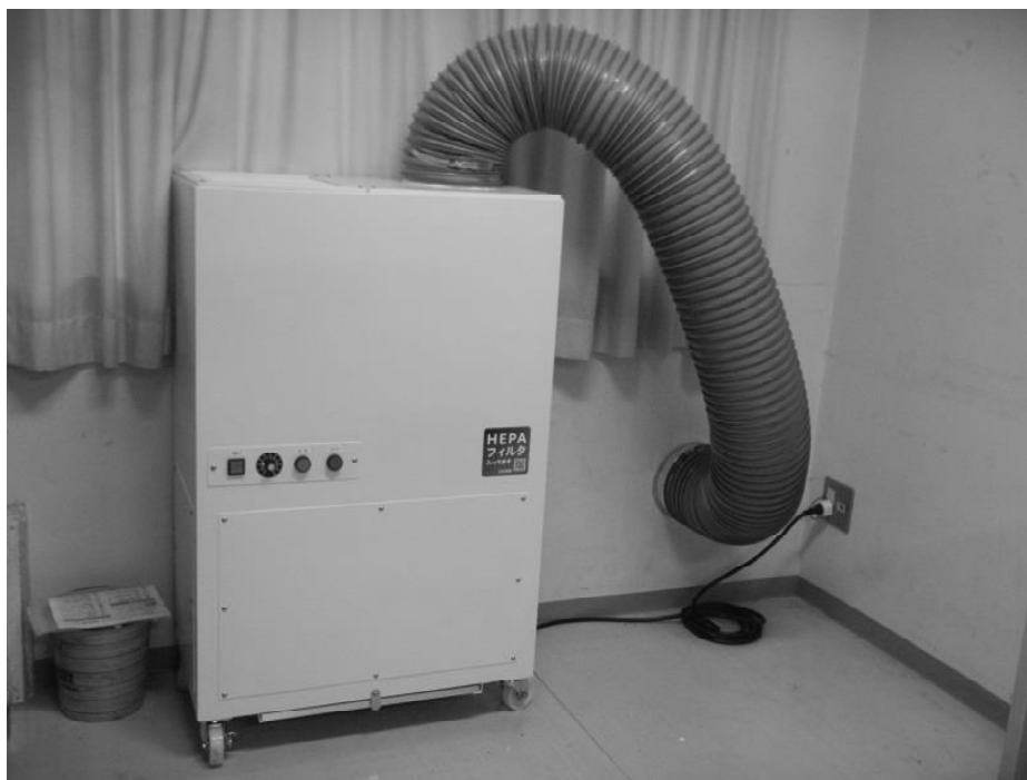
特別養護老人ホーム高浜安立荘が設置した簡易陰圧装置
