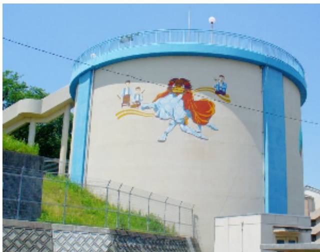
図 2 高浜配水場(図 1 中の①)
