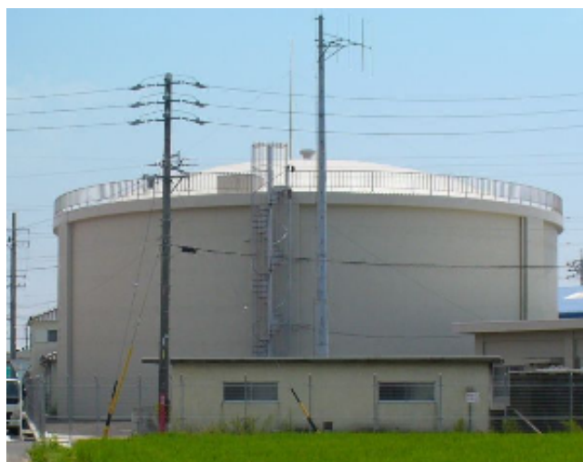
図 3 吉浜配水場(図 1 中の②)
