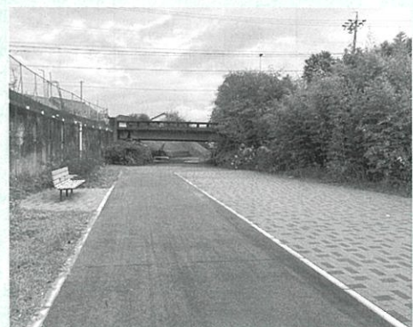
蛇抜橋付近の遊歩道にも「シャモット」が 使用されています。
