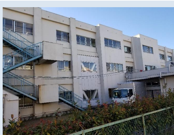
耐震補強工事
