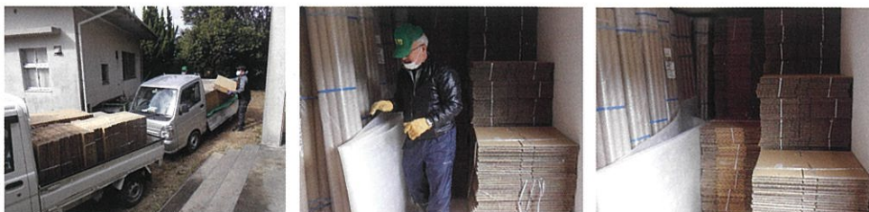
間仕切りカーテンや段ボールベッドなどを搬入 1月30日
