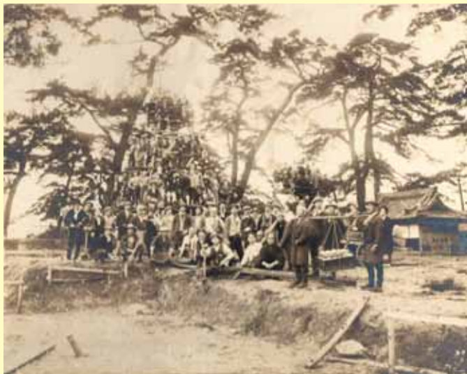
▲昭和12年ごろ・吉浜神明社新築工事での集合写真 (写真：吉浜まちづくり協議会提供)
