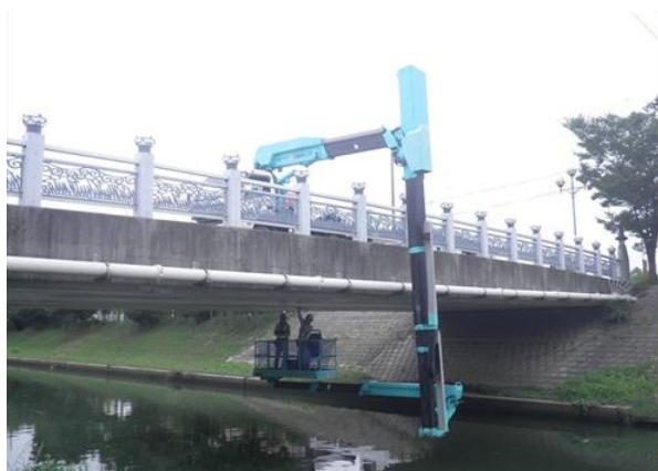
▲橋りょう法定点検状況（吉野橋）
