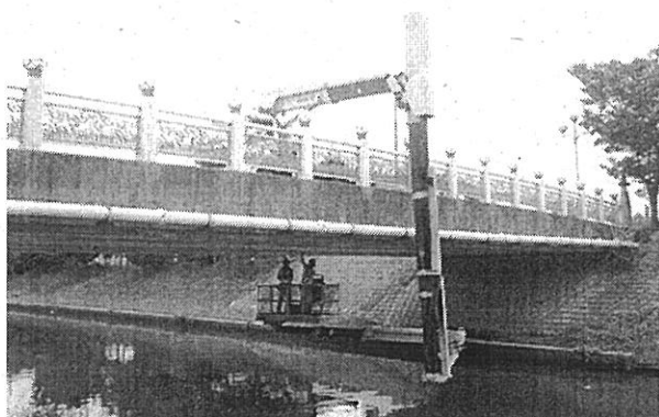
▲橋りょう法定点検状況(吉野橋)
