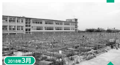
2018年3月 建物の土台を作る基礎工事が進んでいます。
