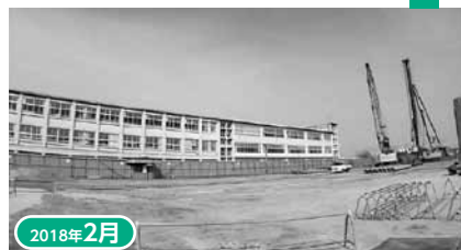
2018年2月 建物を支える杭を打ち込む工事が始まりました。
