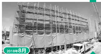
2018年8月 躯体工事が着々と進んでいます。
