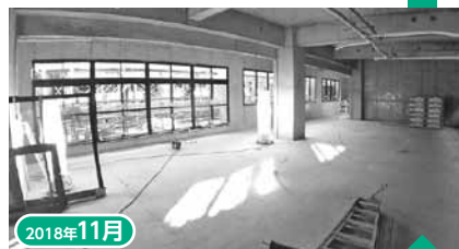
2018年11月 内装工事が始まりました。写真は3階のようすです。
