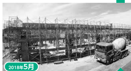
2018年5月 柱・壁・床などを作る躯体工事が始まりました。
