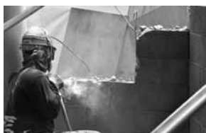
高小ブロック塀工事【7月】
