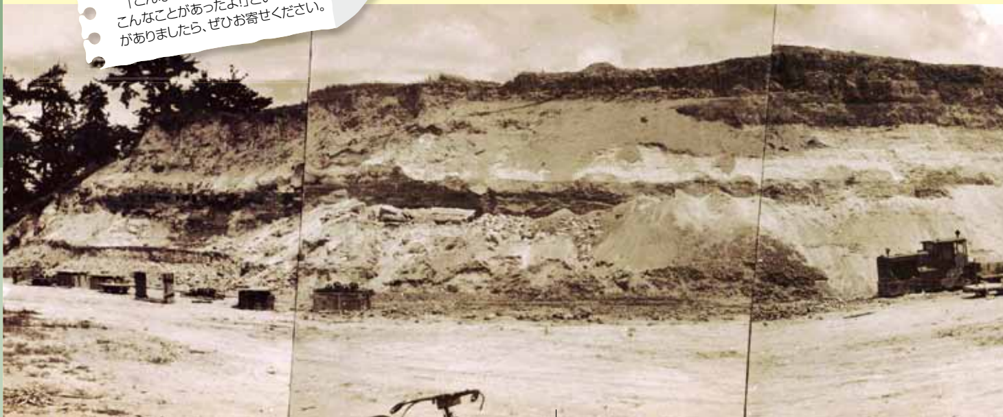
▲昭和28年頃、工事中に南から高平台地を撮影。台地の下には土砂を運ぶために使用したトロッコが確認できる。(高浜市役所蔵)
