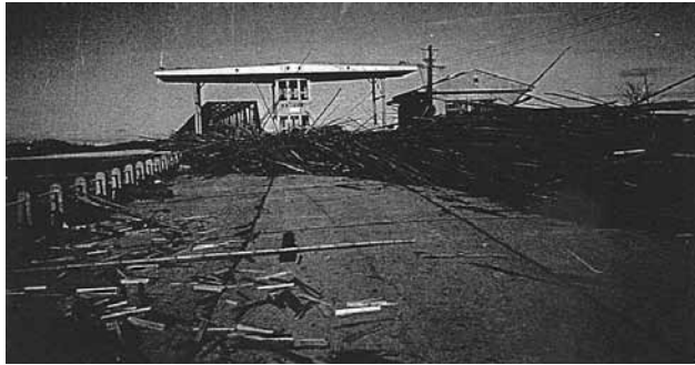
▲衣浦大橋も高潮につかり、流木の山ができています。
