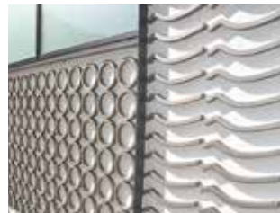
◀1階の外壁や通路には数種類の瓦があしらわれている。 愛知県陶器瓦工業組合より寄贈
