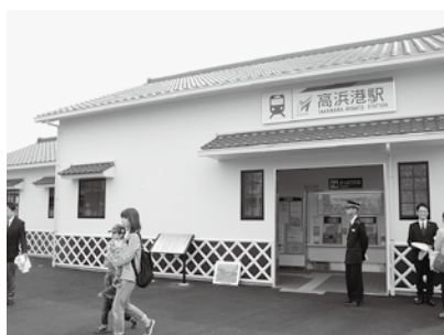
▲目標(6) 高浜港駅新駅舎
