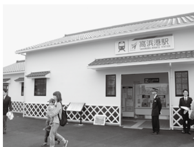
▲目標(6) 高浜港駅新駅舎
