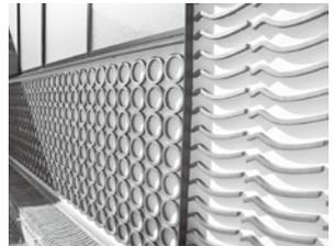
▲新庁舎正面の外壁には、三州瓦が埋め込まれている
