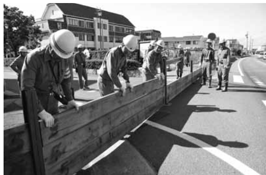
▲せき板の設置
