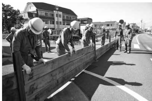
▲せき板の設置
