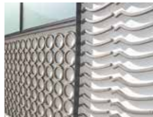
◀1階の外壁や通路には数種類の瓦があしらわれている。 愛知県陶器瓦工業組合より寄贈
